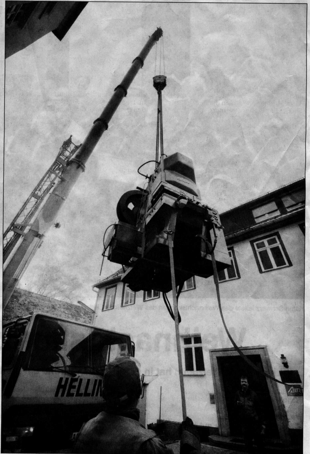
Eine elf Tonnen schwere Presse wird aus dem Gebäude gehievt.
